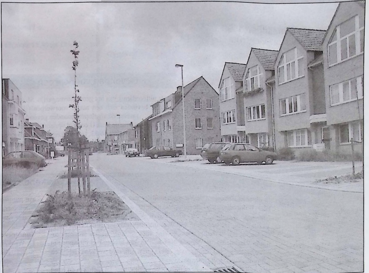
In de Bosduinstraat werd ter gelegenheid van de verfraaiingswerken tussen Bredabaan en Oude Baan een fietspad aangelegd.
