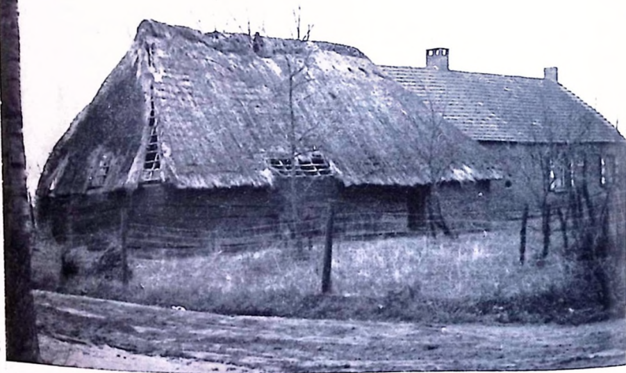
Afb. 6. — Het geboortehuis van de conscrit Kenis op het Neerven te Loenhout in zijn huidige toestand. Het woonhuis werd hoger opgetrokken en voorzien van een pannendak. Alleen het bijgebouw op de voorgrond is in zijn oorspronkelijke staat bewaard gebleven.
