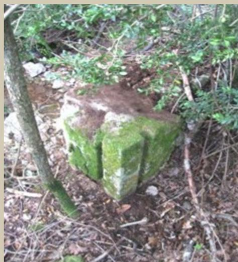
Martelière sur le pont canal : un système de trappe permettait de réguler le flux ou de le diriger vers le ruisseau au besoin
