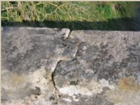
Détail de l'emboîtement par tenon et mortaise
