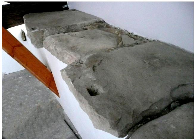
Dallage du chemin de ronde – Détail des dalles où l'on remarque des orifices sur une pierre sur deux, servant peut-être pour une rampe coté intérieur (Merci Bernard COUIC !)
