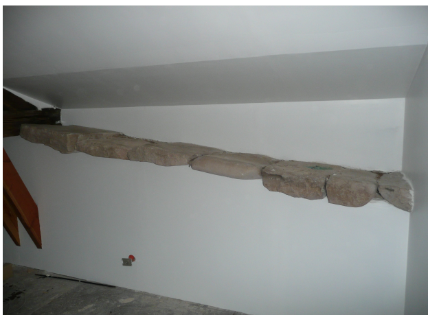
Dallage du chemin de ronde – Détail des dalles où l'on remarque des orifices sur une pierre sur deux, servant peut-être pour une rampe coté intérieur (Merci Bernard COUIC !)
