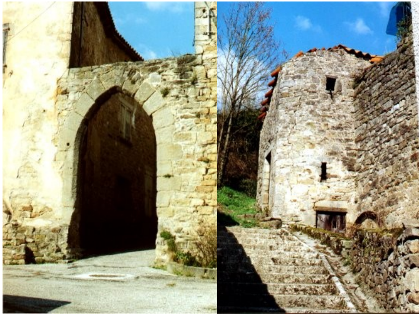
Porte Saint-Jean en arc brisé - La tour Nord-Ouest côté Sud
