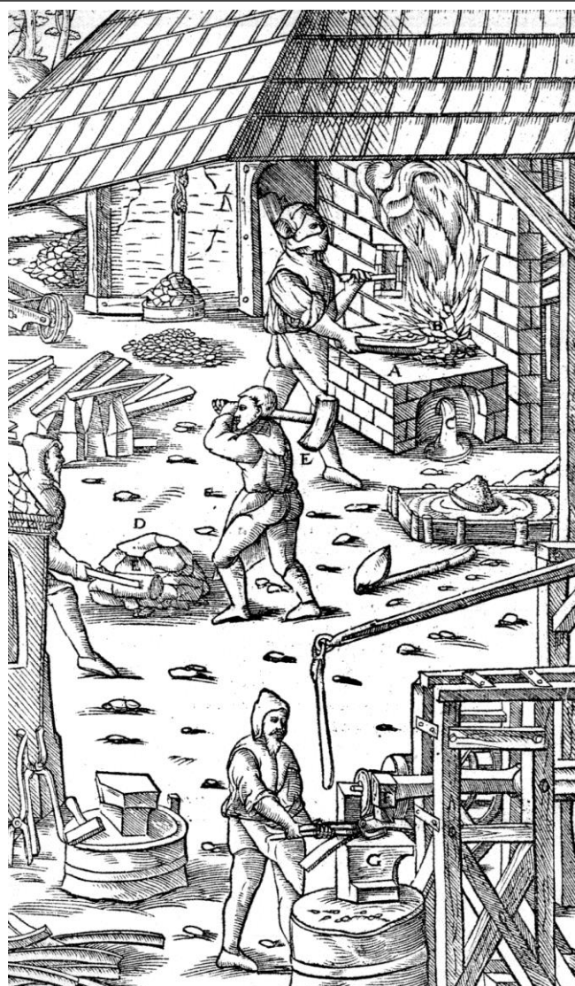
Die Innendarstellung einer Hammerhütte. Diese entspricht der ländlichen Bauweise des 15. und der 1. Hälfte des 16. Jahrhunderts im Erzgebirge. Fast alle Produktionsbereiche befanden sich unter einem Dach. Das Gebäude ist ein Fachwerkbau. Das Dach und vermutlich auch der Rauchabzug sind mit Holzschindeln gedeckt.
