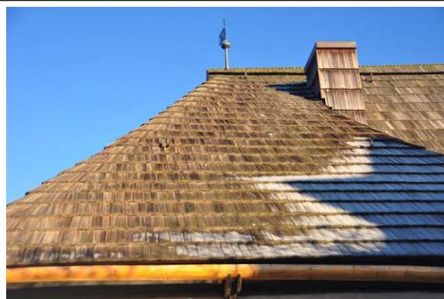
Detailaufnahme der Südseite des Frohnauer Hammers. Hier sind auch die Dachrinnen aus Holz gefertigt.
