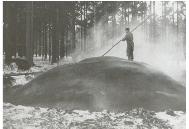
7) Der obere Teil des Meilers ist etwas eingesunken
