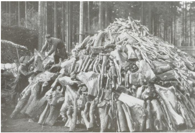
4) Der Meiler wird aufgesetzt
