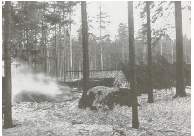
12) Nahezu niedergebrannter Meiler. Rechts
