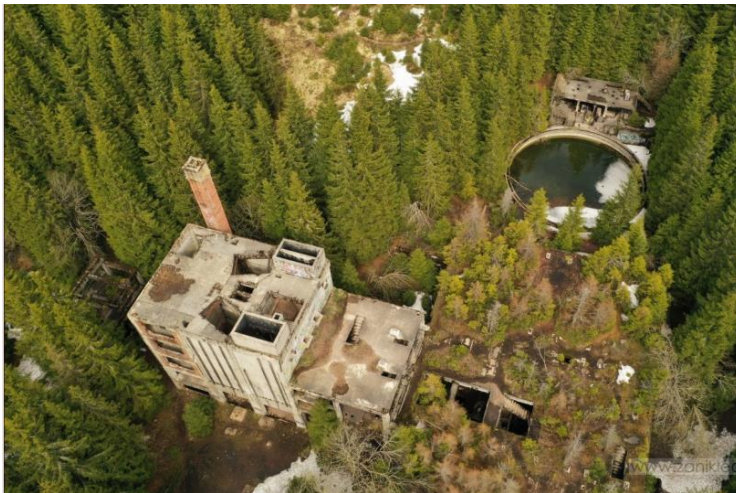
Gebäude der Aufbe- reitungs- anlage und nahe gelegener Schlamm- verdichter auf einem Luftbild aus Frühjahr 2019 (Foto: P. Beran, zanikle- obce.cz)
