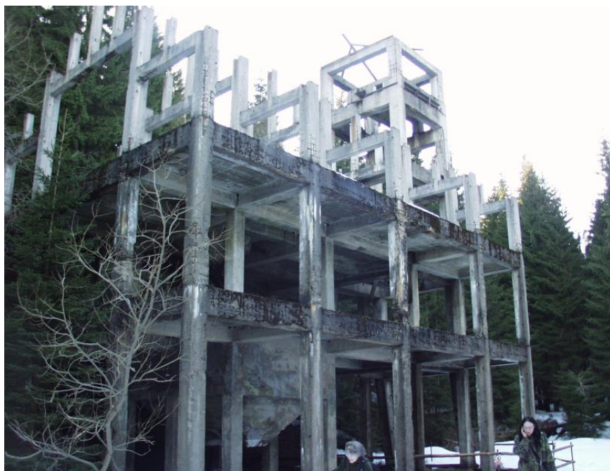
Betonskelet des Hauptschachtes (Foto P. Rojík)
