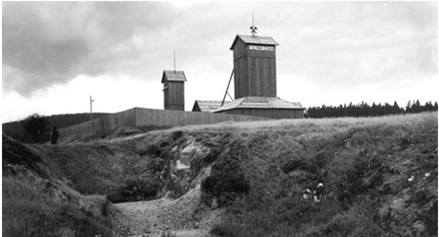
Ritter-Schacht im Jahre 1940, im Vordergrund ist ein alter Pingenzug sichtbar
