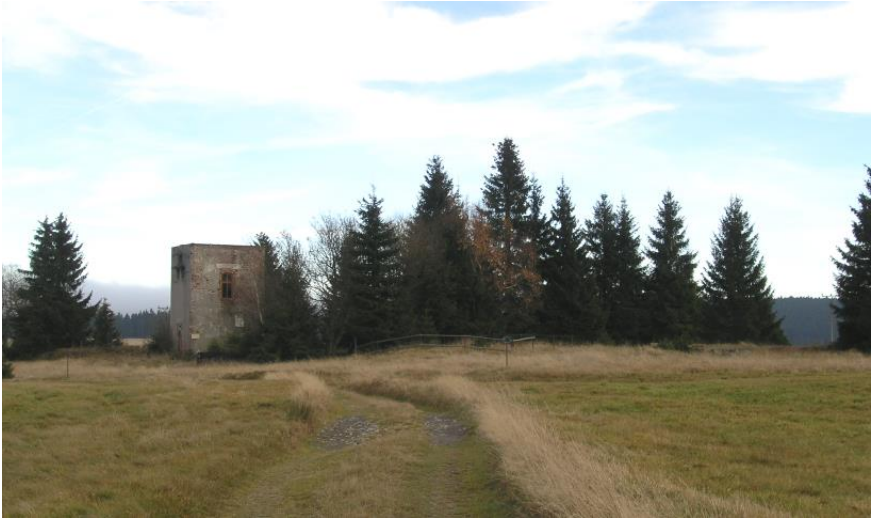
Ehemalige Trafostation beim Ritter-Schacht (Foto M. Urban, 2011)
