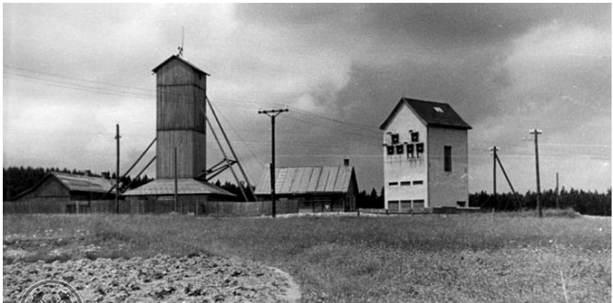
Förderturm, Maschinen- und Trafohaus des Ritter-Schachtes im Jahre 1946 (Foto R. Hylský, Archiv des Tschechischen geologischen Dienstes)
