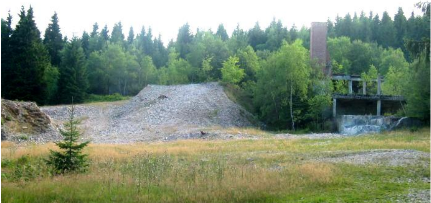
Erzhalde aus der bergmännischen Erkundung in den 1950er Jahren, heute bereits weggefahren, rechts die Reste der Aufbereitungsanlage (Foto B. Mičoch, 2003)
