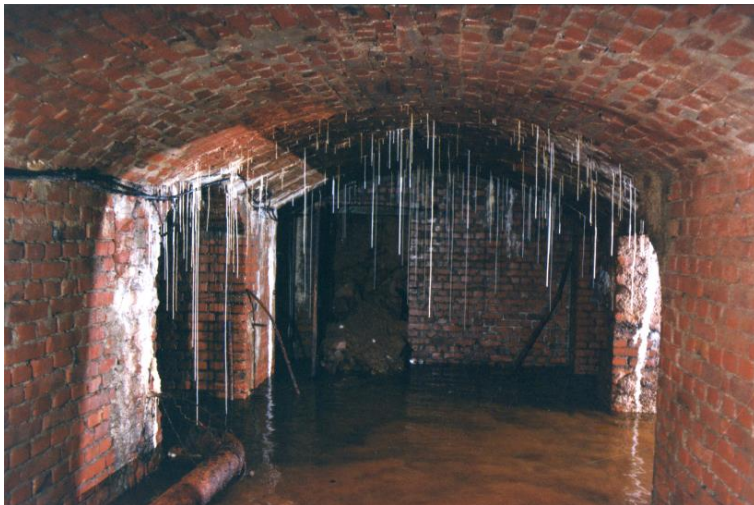
Klinkergewölbe auf der Kreuzung der zwei Hauptstrecken auf der Sohle -60 m (Foto: J. Andrle, 1999)
