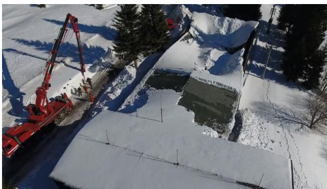
Eingebrochenes Dach der Wasseraufbereitung Quelle: HZS Karlovarského kraje
