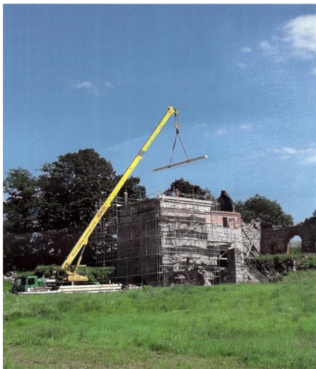
Mobilkran beim Aufbau des Dachstuhles
