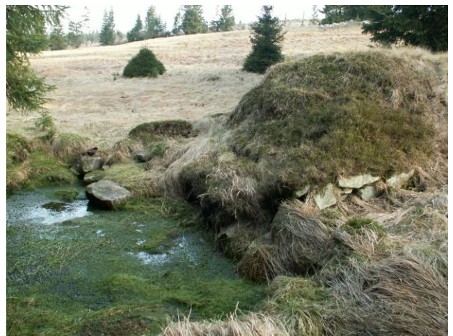
Gebrochener Damm des Teiches oberhalb des Schindelwerkes
