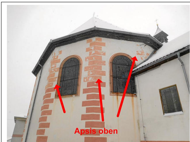
Schäden an der Apsis oben, 22.10.2016
