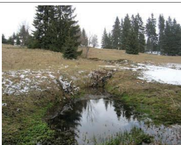
Das Mundloch des Blasius Stollens ist zwar verbrochen, seine Entwässerungsfunktion allerdings erfüllt er noch zeitweise
