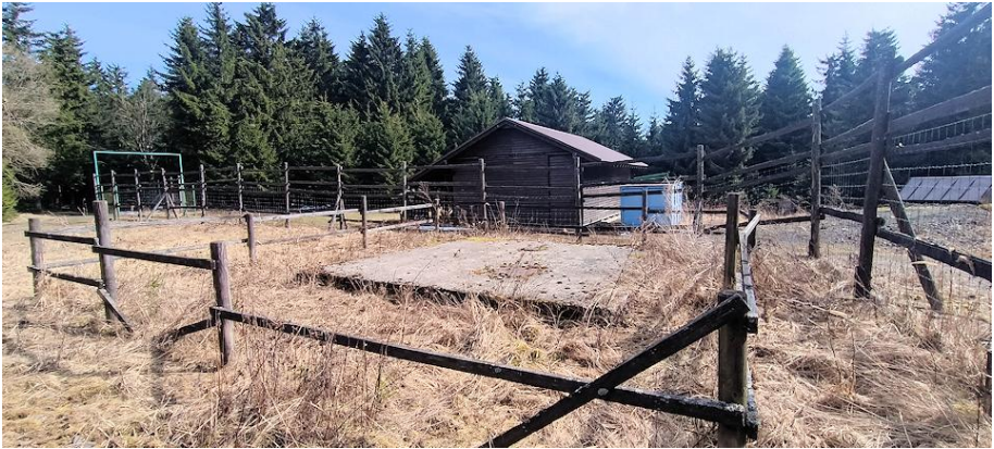
Betonplatte an der Schachttöffnung (Foto: Michal Urban, 2026).
