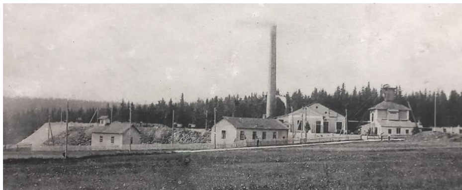
Fischer-Zeche um 1910: Rechts die Schachtgebäude, in der Mitte ein Maschinenhaus, in dem eine Dampfförderanlage stand, mit Schornstein; außerhalb des Bildausschnitts rechts befand sich eine Trafostation.
