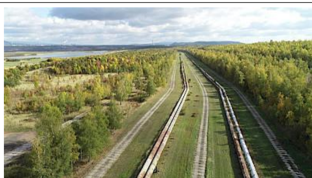
Der Fluss Bílina in Rohren (© Povodí Ohře)
