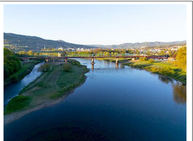
Fußgänger- und Radfahrerbrücke über die Elbe in Děčín
