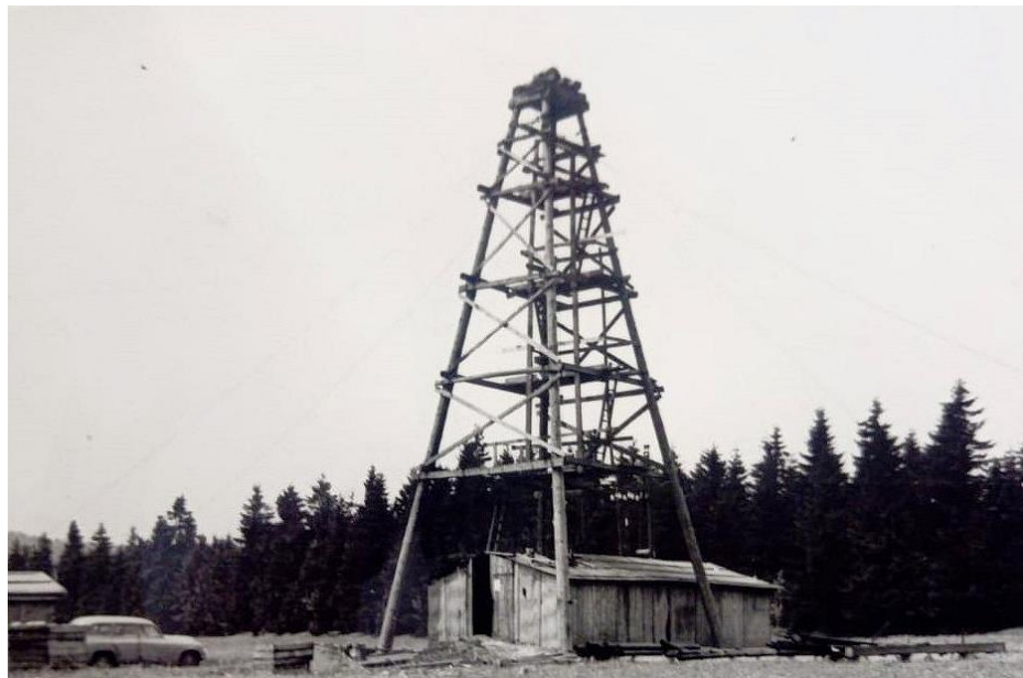
In der Gegend um Pernink wurden auch Bohrungen zur Erkundung von Uranerzen durchgeführt. Das Bild zeigt die Bohranlage Nr. 62 mit unbekanntem Standort, das Bohrloch stieß auf eine Übergangszone zwischen der Schiefer- und Phyllit-Zone.
