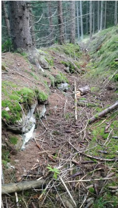
Blaufarbenwerk-Graben, der das Antriebsswasser zur Kobaltmühle vom Breitenbach zuführte, und der Wassergraben vom Tichý Bach (Foto: Michal Urban)
