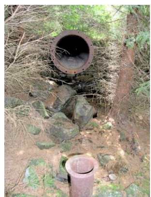
Blaufarbenwerk-Graben, der das Antriebsswasser zur Kobaltmühle vom Breitenbach zuführte, und der Wassergraben vom Tichý Bach (Foto: Michal Urban)
