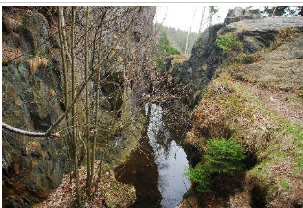
Grabenquerschnitt wurde aus dem Hang gehauen
