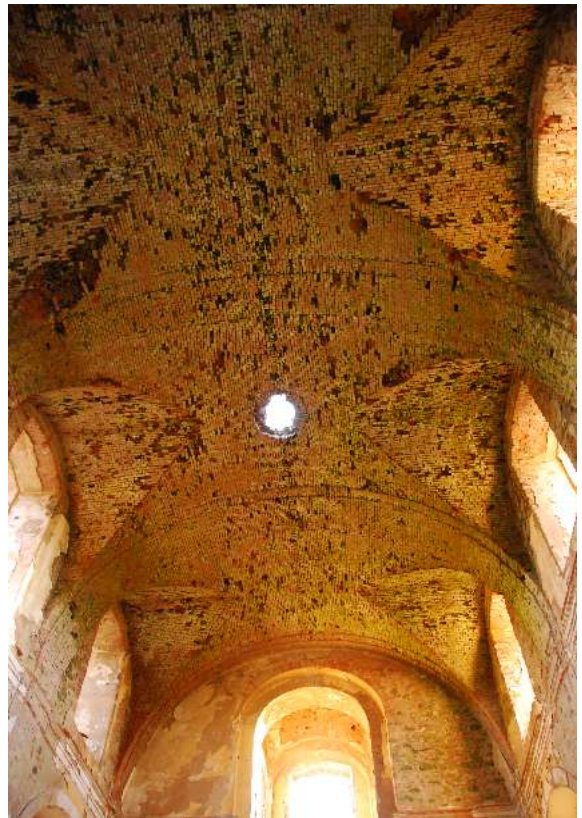
Innenansicht mit der gewölbten Ziegeldecke
