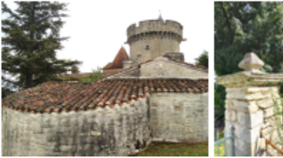
Le four banal accessible par une porte « dérobée »
