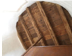
coffrage de l'échauguette et charpente de la tour à vis d'accès au logis
