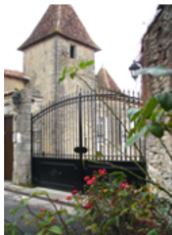
Porte actuelle d'accès à la cour, avec passage piéton
