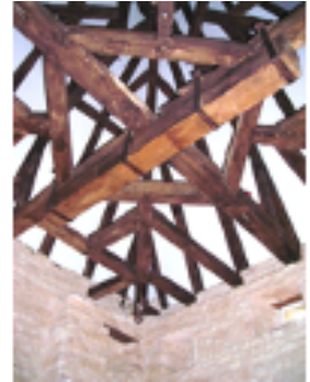
coffrage de l'échauguette et charpente de la tour à vis d'accès au logis
