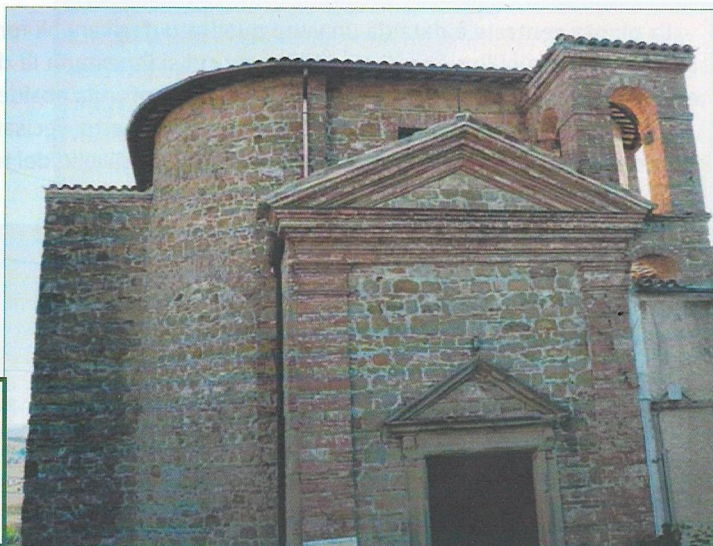
Facciata e cella campanaria
