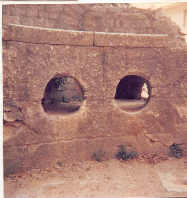
(3) Die Verteilerroh- re des castellum
