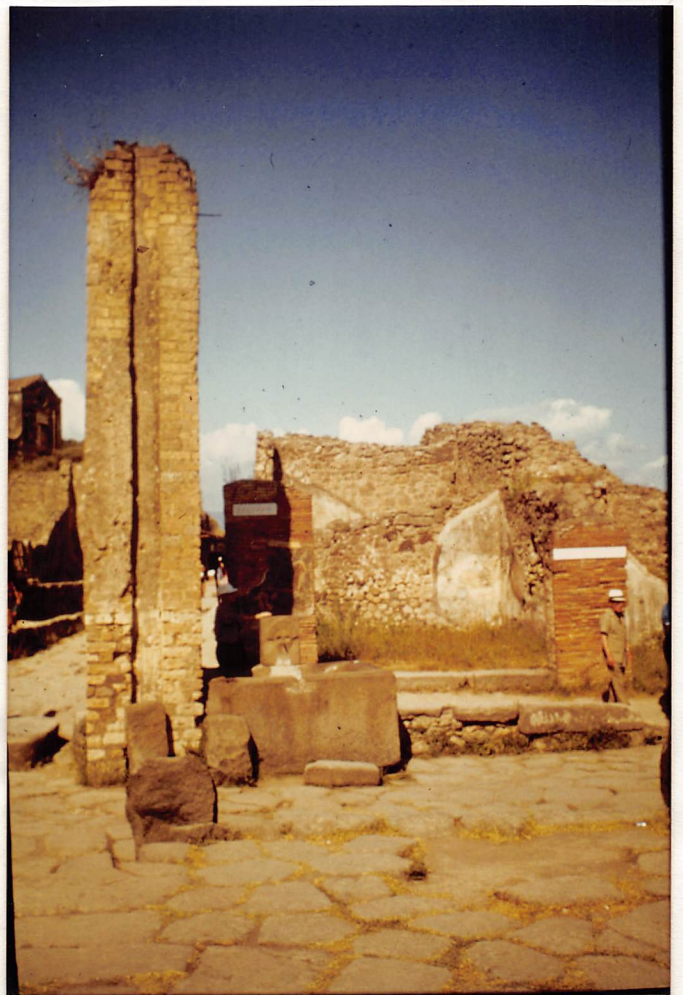
(1) Straßenbrunnen ; links daneben: Pfosten einer Steigleitung
